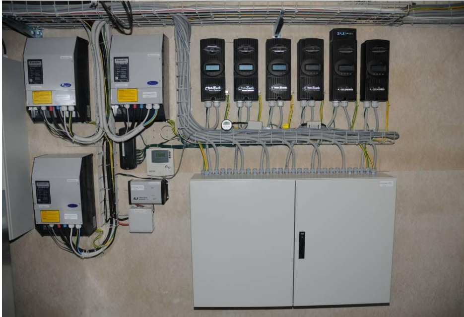
Abb 4: Installation der Solartechnik
